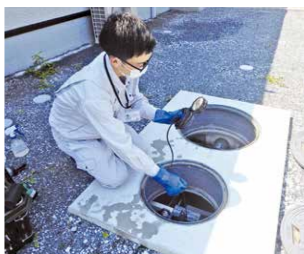
浄化槽の設置場所での検査
